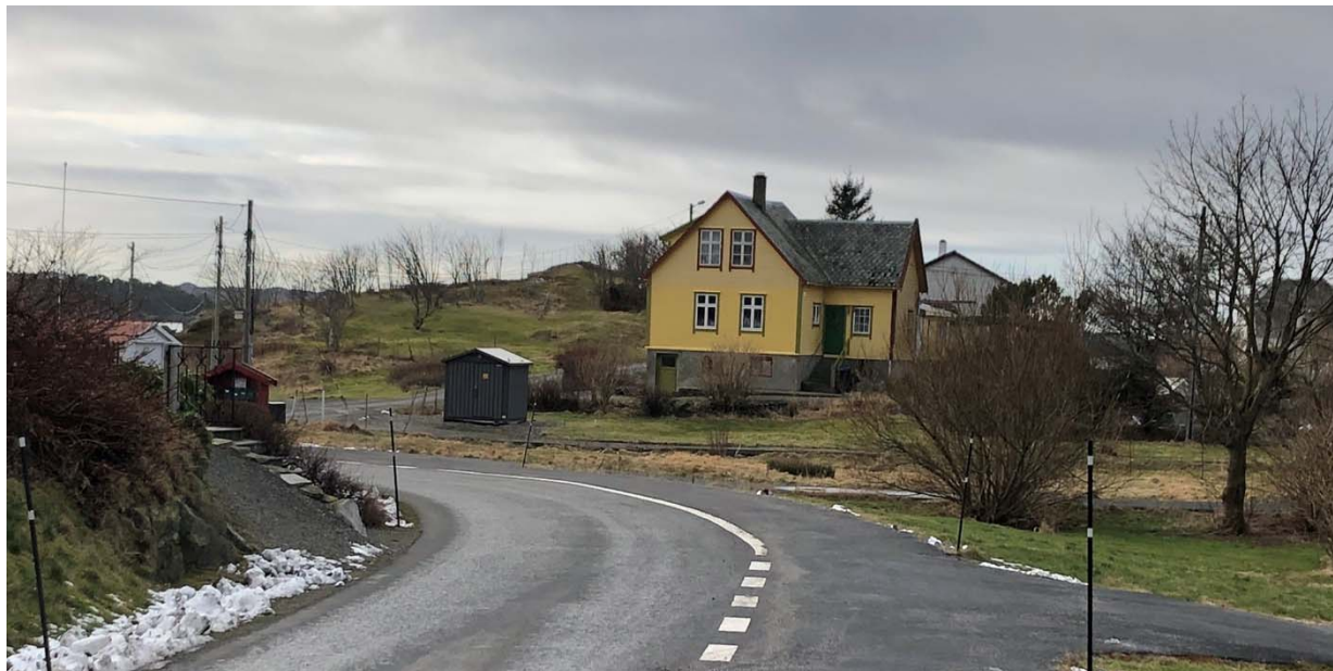
Figur 7-11 Fortau i Nedgardsvika er planlagt markert med strek i vegen, slik løysinga er lengre sør mot Nesevågen, vist i biletet.
