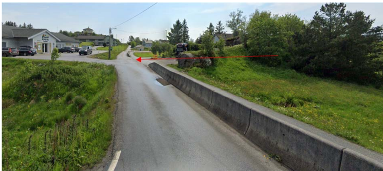
Figur 8-15 SKV2 i retning sør. Avkøyrsla flyttet 40 meter sør er illustrert med rød pil. Bilde: Google Maps, juni 2019.
