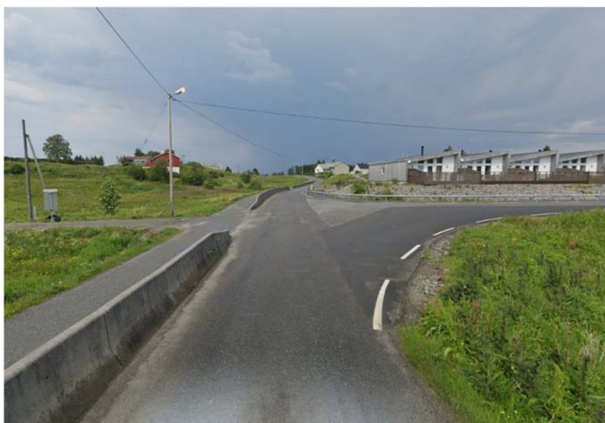
Figur 8-16 SKV2 i retning nord. Rekkverk langs vegane som er med på å lede trafikken, for både harde og mjuke trafikantar. Bilde: Google Maps, juni 2019.
