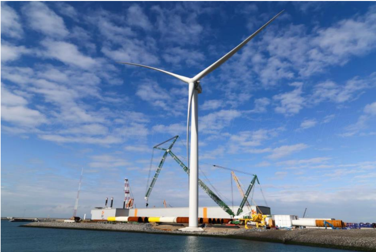
GEs testturbin (Haliade-X 12 MW) i Rotterdam hamn. Kjelde: Melding - Testanlegg for en havvindturbin i Sløvåg, Wergeland Group AS, 2023
