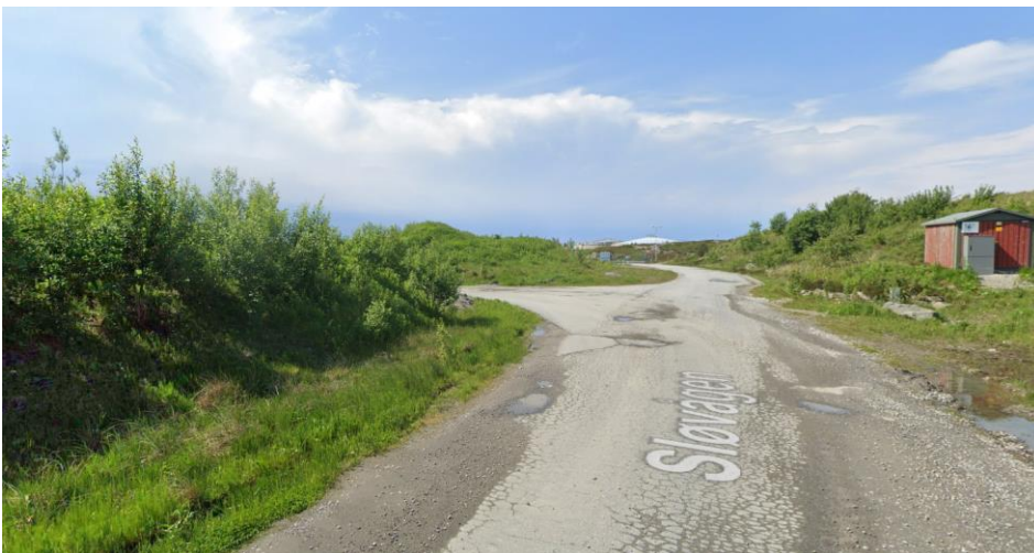
Figur 9: Dårlig sikt på grunn av voll/terreng her sett fra øst mot vest. Avkjørselen er lenger fremme til høyre i bildet (Kilde: Google Street View)
